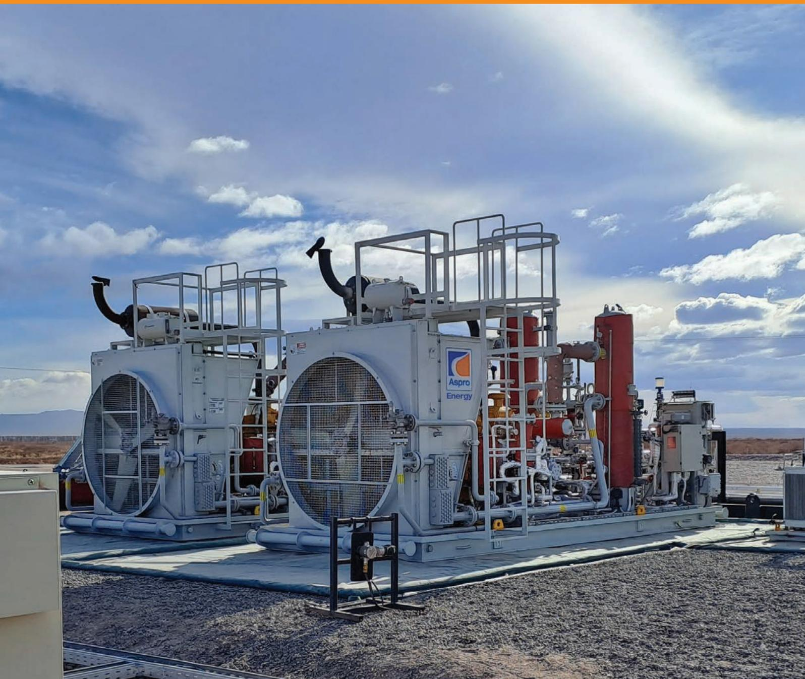
Cuenta con una válvula de control de presión a la entrada para regular la presión en la succión del equipo. Funciona como válvula de cierre rápido SHUT DOWN para aislar la máquina del pozo o gasoducto.
